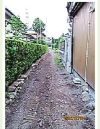
川寺 雨水排水
